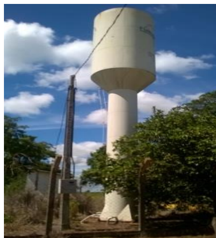
FIGURA 64: RESERVATÓRIO DO ASSENTAMENTO RURAL SÃO CRISTÓVÃO.
