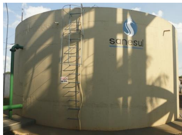
FIGURA 12: RESERVATÓRIO APOIADO NO PONTO AGU 01.
