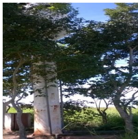
FIGURA 51: RESERVATÓRIO DA ALDEIA INDÍGENA PARAGUASSÚ.
