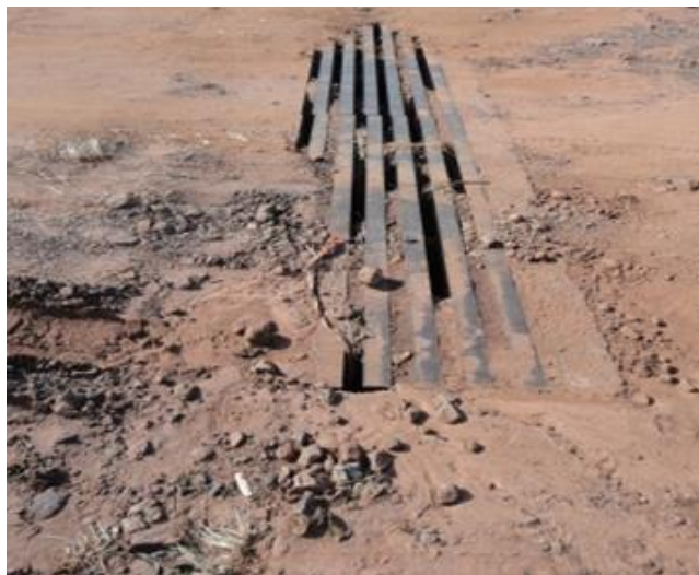
FIGURA 37: BOCA DE DRAGÃO ASSOREADA.
