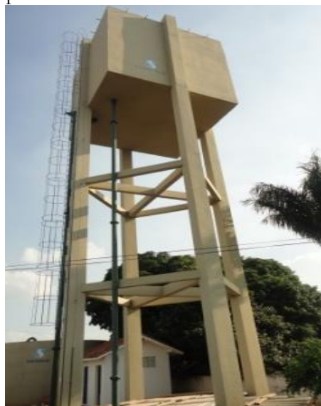
FIGURA 10: RESERVATÓRIO ELEVADO NO PONTO AGU 01.
