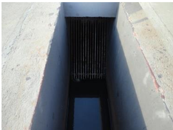
FIGURA 20: GRADEAMENTO NO PONTO ESG 01.
