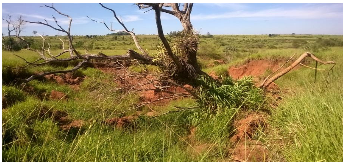
FIGURA 47: EROSIÃO NO SOLO DA ALDEIA ARROIO CORÁ POR PROBLEMA DE DRENAGEM PLUVIAL.
