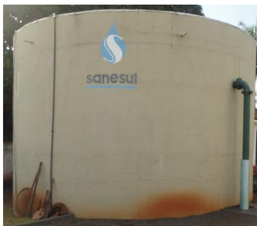
FIGURA 11: RESERVATÓRIO APOIADO NO PONTO AGU 01.
